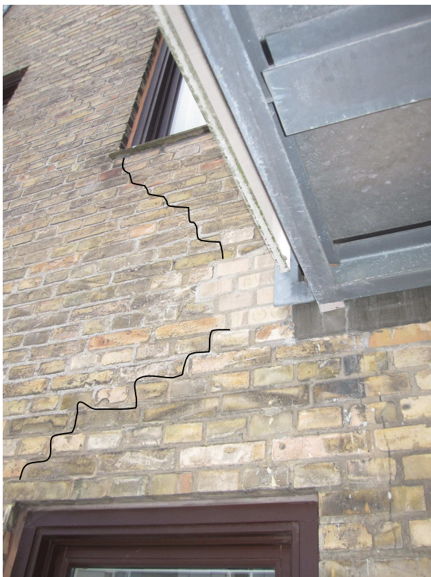
5. Buntmagervej 14, 2. tv. vestfacade. "Lyn" i murværk som følge af spændingsudløsning i murværk efter rustudvidelse af vederlagsplade. "lyn" er fremhævet med sort tusch.
