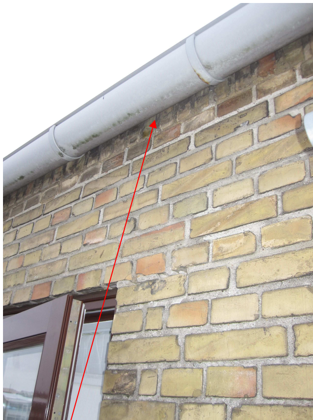
4. Mørtelfuger i rulleskifte er udvaskede.
