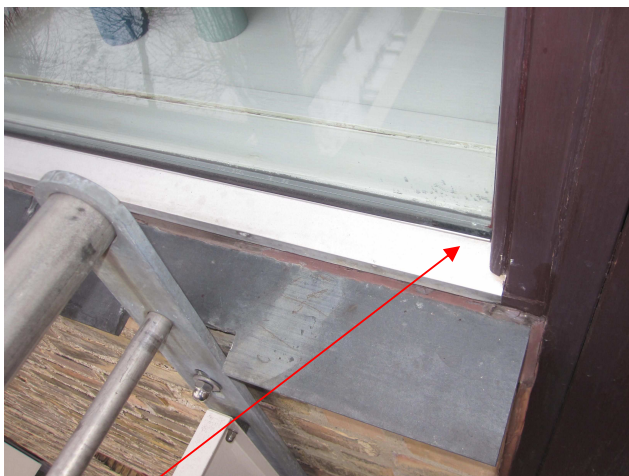
1. Gummiliste mellem vindue og bundliste er krøbet, hvorved vand kan trænge ind i vindueskonstruktionen.
