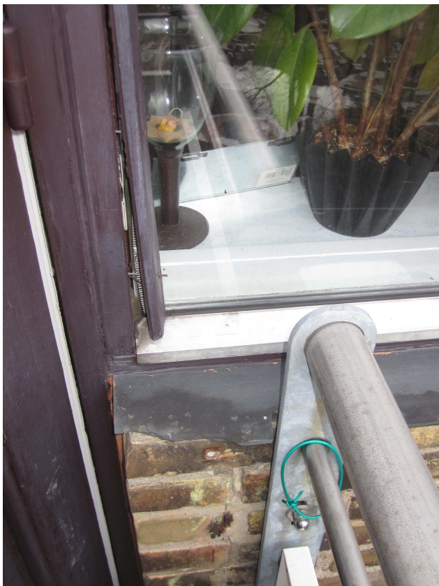
3. Buntmagervej 2, tv. Løs sideliste i vindue.
