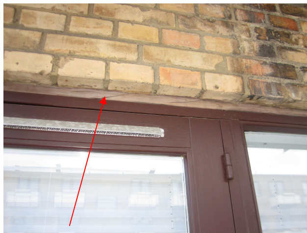
2. Revnet/utæt kalfatningsfuge. Hér Buntmagervej 6, 2. th.
